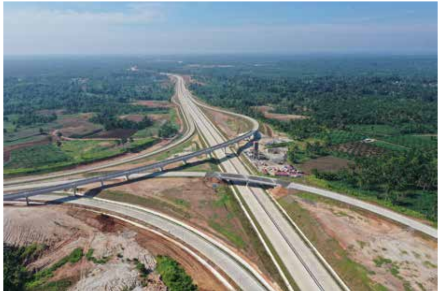
Simpang susun Jalan Tol Indrapura-Kisaran, Sumatera Utara.
